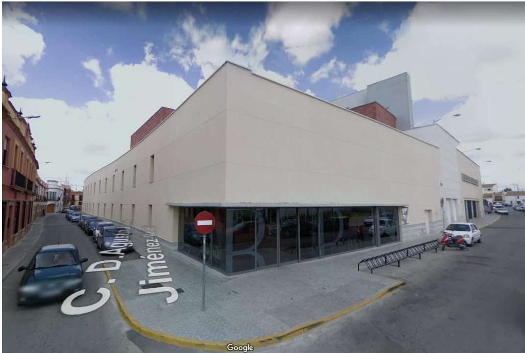
Figura nº2. Vista de la fachada delantera del inmueble afectado (Sede Virtual del Catastro, 2021)
